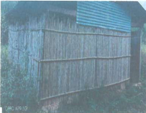
Foto 3: Mejora estructura de aula, techo lamina troquel. Calibre 28 y mejora en puerta e instalación.
