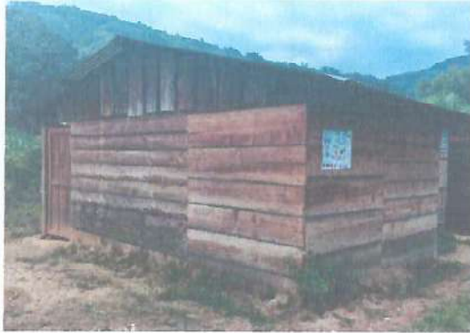
Foto 1: Mejora estructura de cocina, techo lamina troquel. Calibre 28 y mejora en puerta e instalación.
